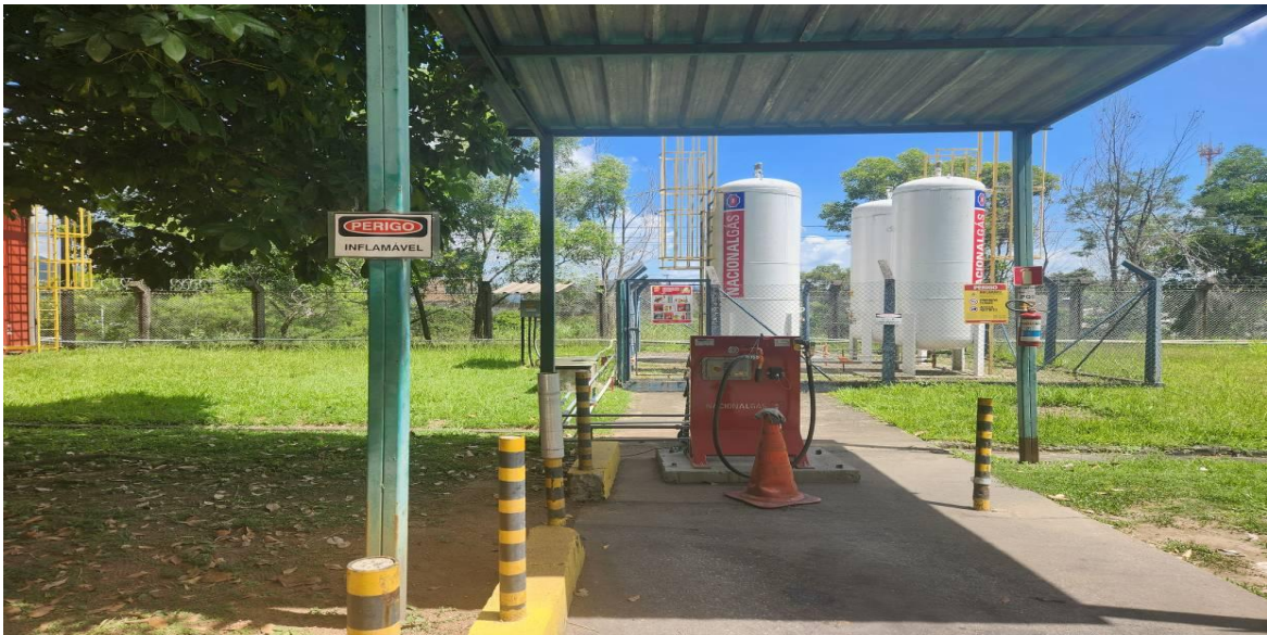
Área de armazenamento e da Bomba de Gás. - Local onde era realizado o abastecimento das empilhadeiras pelo Reclamante de forma habitual em sistema de Pit-Stop.
