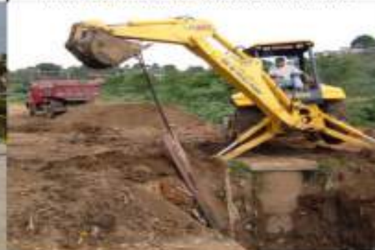
REDE COLETORA DE ESGOTO EM REPARO
